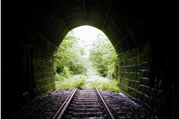
Foto 1 Tunnel bei Voglöd: Abenteuerstrecke für Radler?
