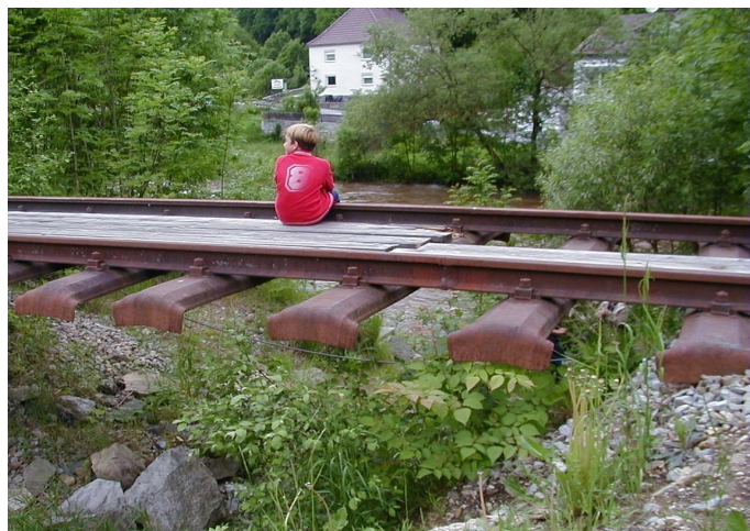
Foto 2 Unterspülte Schienen bei Voglöd.
